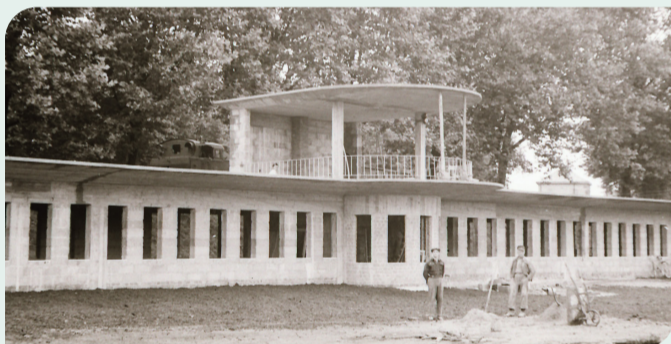
Bauarbeiten auf der Neusser Galopprennbahn vor der Wiedereröffnung am 12.08.1951 – Stadtarchiv Neuss
